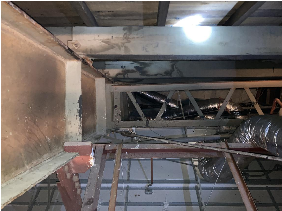
圖 2.14 橫向鐵架與 I 型鋼架現貌照片
