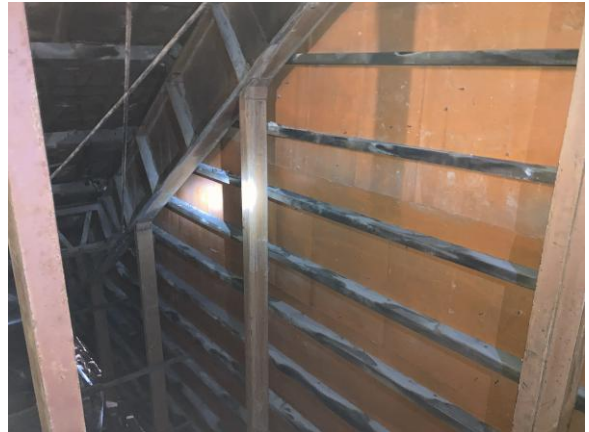
圖 2.17 木製山牆內部構造現貌(內部包覆鉛板)
