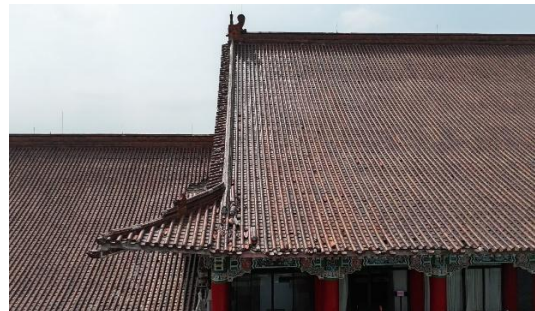
圖 2.29 屋瓦脫落
