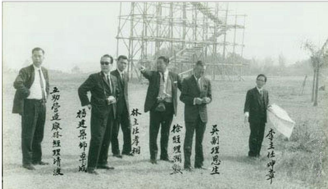
圖 2.2 推測為飯店興建初期的基地現場照片
