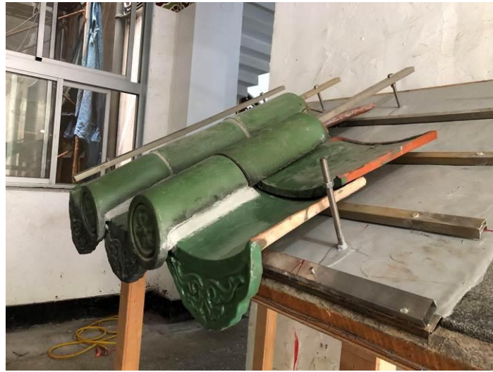
圖 3.2 中國式瓦(半)乾式施工 1:1 模型大樣
