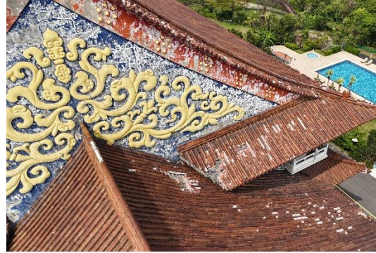
圖 2.40 脊筒瓦脫落
