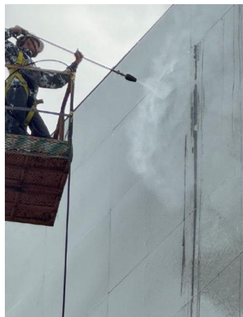
圖 4.16 高壓清洗機清洗外牆面
