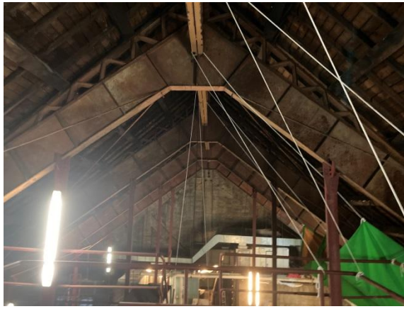
圖 2.10 中央處以鐵架增高之實際現場情形
