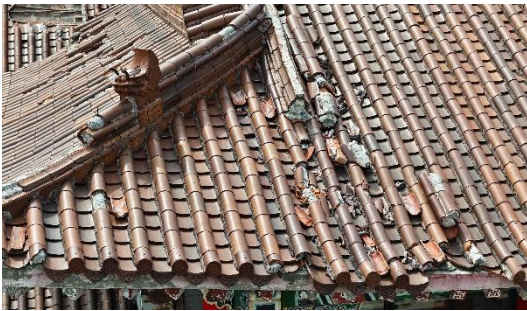
圖 2.28 屋瓦破損
