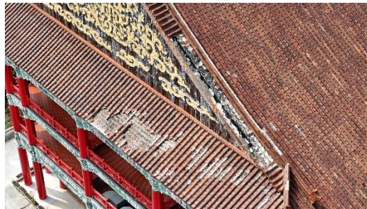
圖 2.30 屋瓦脫落
