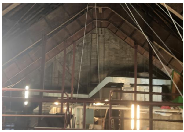
圖 2.19 RC 山牆內所示 M 型構架
